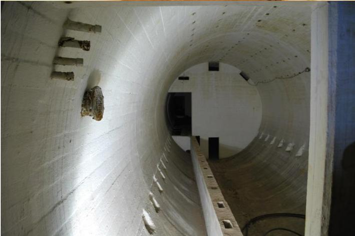
Ausgebauter Nebenstollen. Im unteren Bereich sollte die Verkabelung eingezogen werden, darüber wird ein Fußboden eingebaut.
