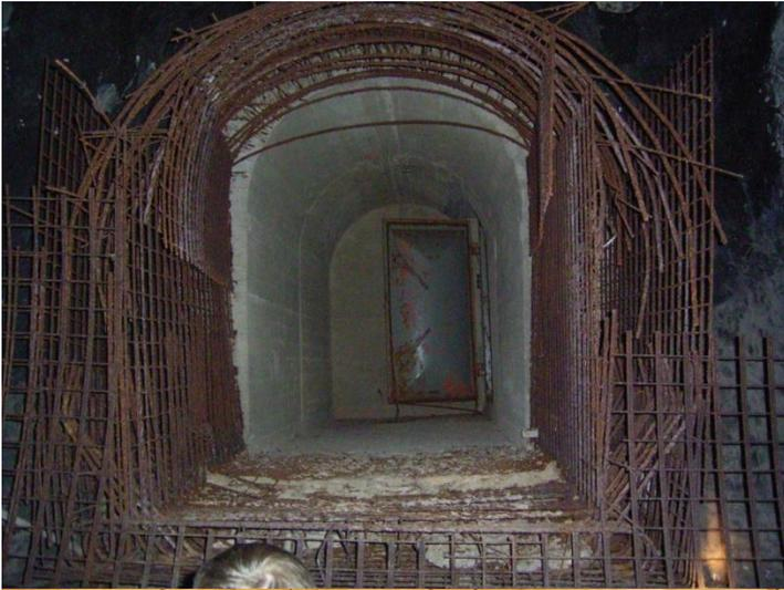
Blick in den Stollenbunker. Im vorderen Bereich erkennt man, dass der Bunker noch nicht fertiggestellt wurde. Die Eisenarmierung ist deutlich zu sehen. Im hinteren Bereich wurde bereits mit Beton ausgefüllt und Stahltüren eingesetzt.
