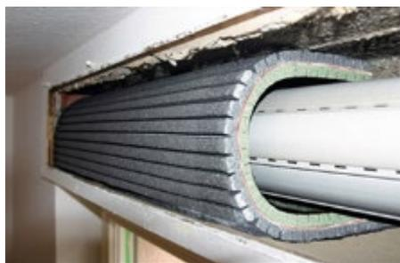
Abbildung 6: Rollladenkastendämmung<sup>5</sup>
