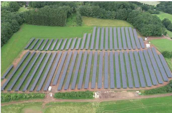
Nach nur zehn Wochen Bauzeit wurde im Sommer der Solarpark Lockweiler in Betrieb genommen. Mit einer Jahresproduktion von 3.600.000 KWh können theoretisch über 1000 Haushalte versorgt werden. Foto: Stadt Wadern
